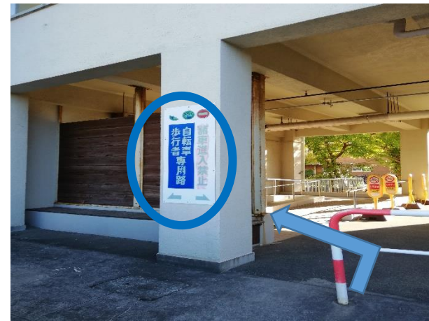
③「自転車歩行者専用路」の裏側に、A棟入口
