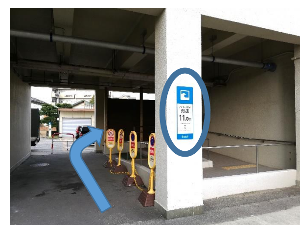
③「海拔11.0メートル」の看板の後ろに、A棟入口
