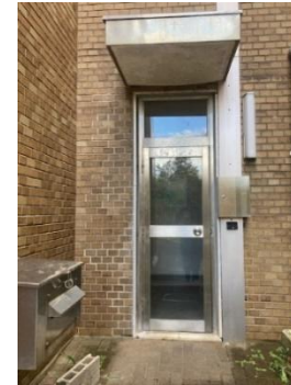
④小さな扉が！！ ドアノブを引いて…
