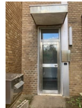
④小さな扉が！！ 勇気を出して開いてみて
